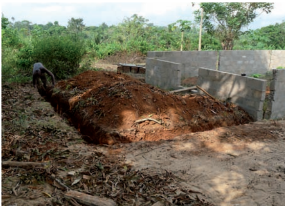
Scuola e mensa nelle prime fasi di costruzione
