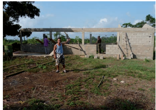
Scuola e mensa in fase di costruzione
